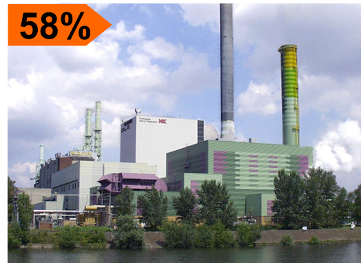
CCPP Mainz-Wiesbaden, 400 MW
