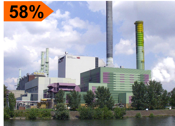
CCPP Mainz-Wiesbaden, 400 MW
