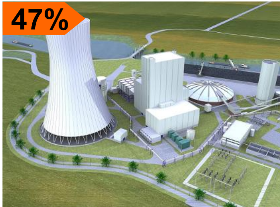
Referenzkraftwerk 600 MW Deutschland
